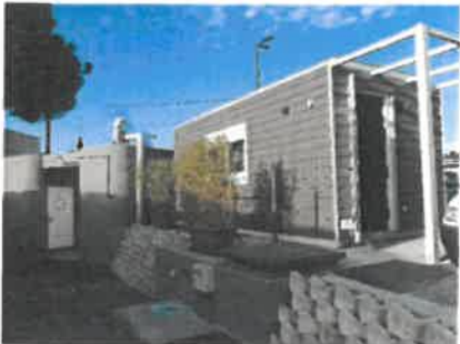
L'ALGECO est installé à côté de la chaufferie de la piscine
